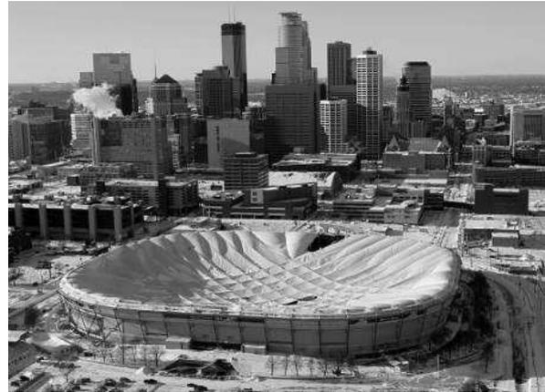
図 5-4 積雪により屋根が崩壊したメトロドーム
